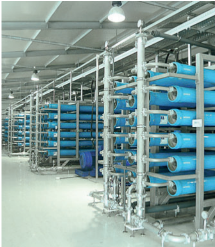
Umkehrosmoseanlage. Quelle: Watertec T.A. GmbH
