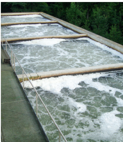
Belebtschlammbecken für die Festbettfiltration
