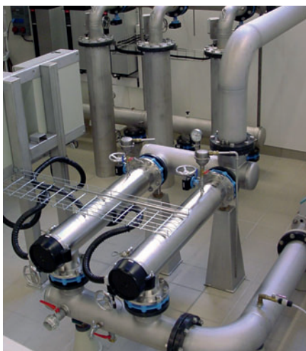
Bestrahlungskammer. Quelle: HydroGroup /Hydro-Elektrik GmbH
