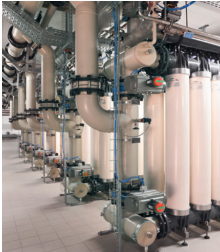
Ultrafiltrationsanlage
