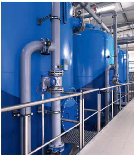
Wasserenthärtungsanlage
