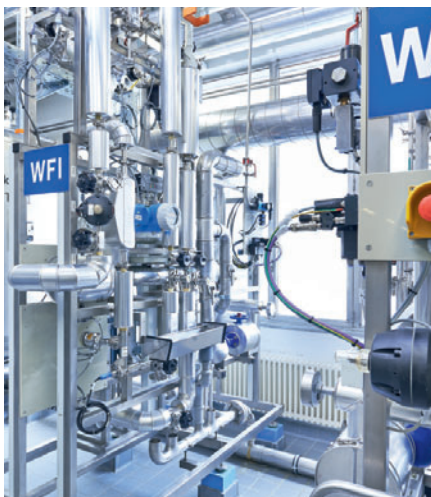
Lager- und Verteilsystem von WFI. Quelle: SH+E GROUP
