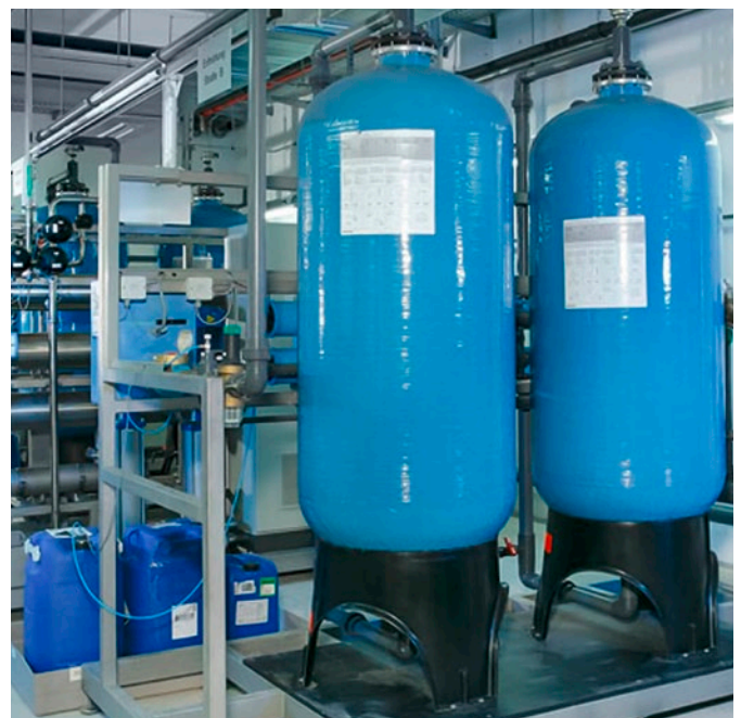
Ionenaustausch zur Aufbereitung von Prozesswasser (z.B. Kesselspeisewasser)
