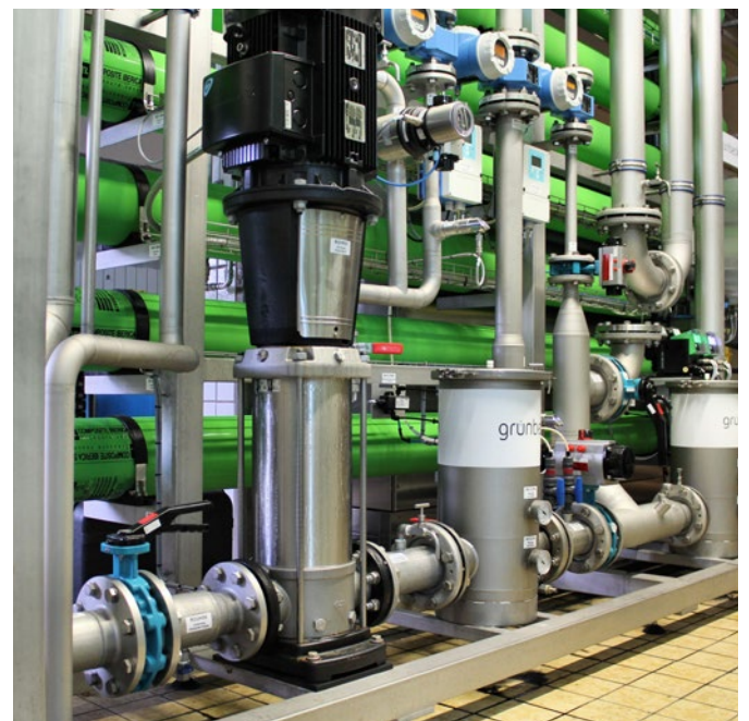
Vorbereitung für die Umkehrosmose in der Meerwasserentsalzung
