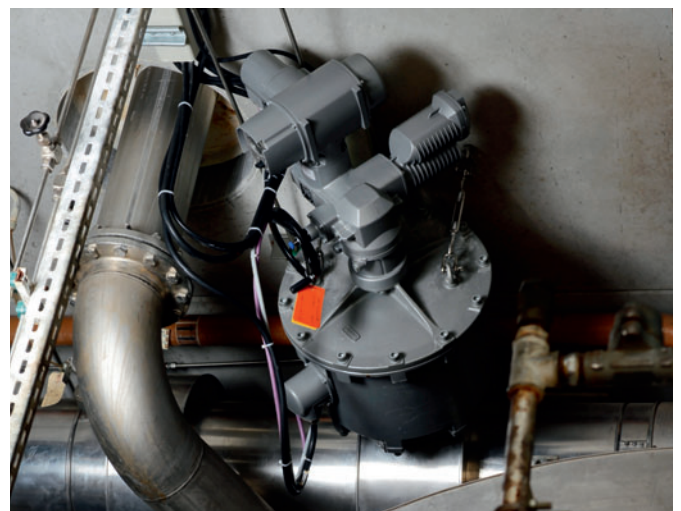
Für den Ernstfall: Bei Stromausfall öffnet die GEMÜ Absperrklappe automatisch, um Schäden in der Anlage zu vermeiden
